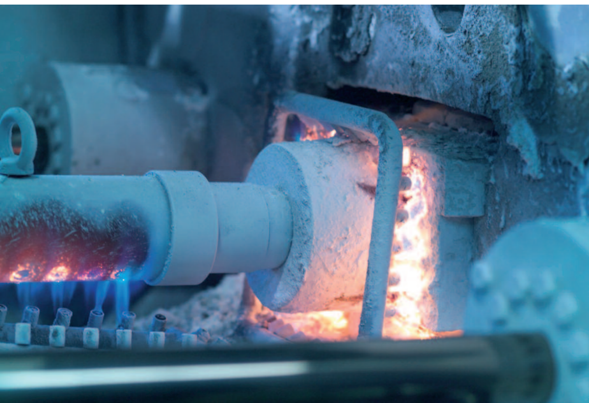
Gasbetriebener Magnesium-druckgussprozess: Ansatzpunkt für eine bivalente Energieversorgung.
