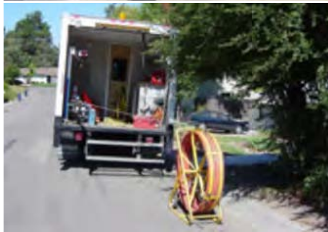
Abb. 3-9.1 Einsetzen eines Kanalinspektionsroboters.
