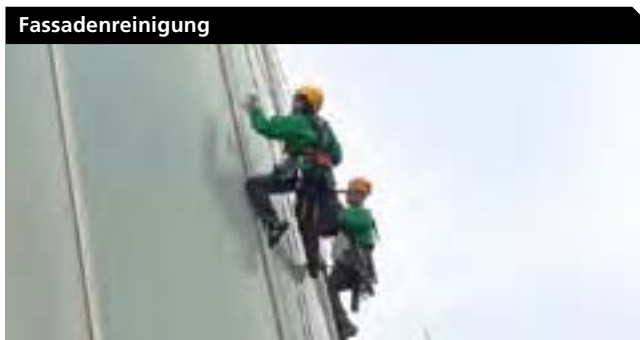
Abb. 3-7.1 Industrie-Kletterer beim Reinigen einer Fassade. Bildrechte gemäß Wikimedia Commons, lizenziert unter GNU/Lizenz für freie Dokumentation, URL: http://de.wikipedia.org/wiki/Datei:Meierbau_cleaning.JPG
