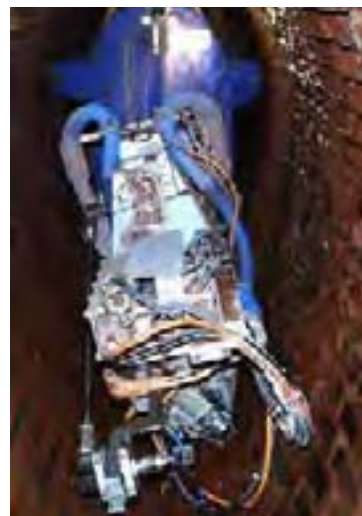
Abb. 3-9.5 Schwemmkanalsanierung
