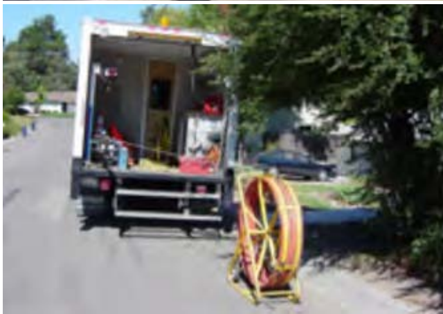
Abb. 3-9.1 Einsetzen eines Kanalinspektionsroboters.
